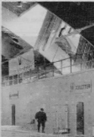
STYRT Det kraftige snefald fik taget på Gigantium i Aalborg til at falde sammen. Foto: Mick Anderson/Polfoto
